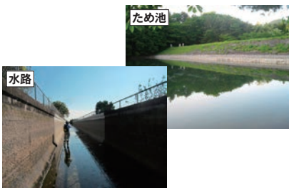
図1 農業用水を貯めるため池・農業用水を運ぶ水路
