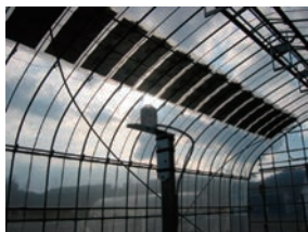
図1 屋根に太陽電池を貼った温室内の光の解析
