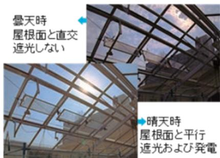
図1 半透過太陽電池を利用した温室自動遮光システム
