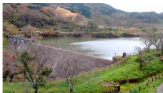
地域の水源地貯水ダム
