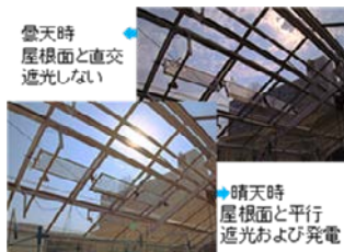
図1 半透過太陽電池を利用した温室自動遮光システム
